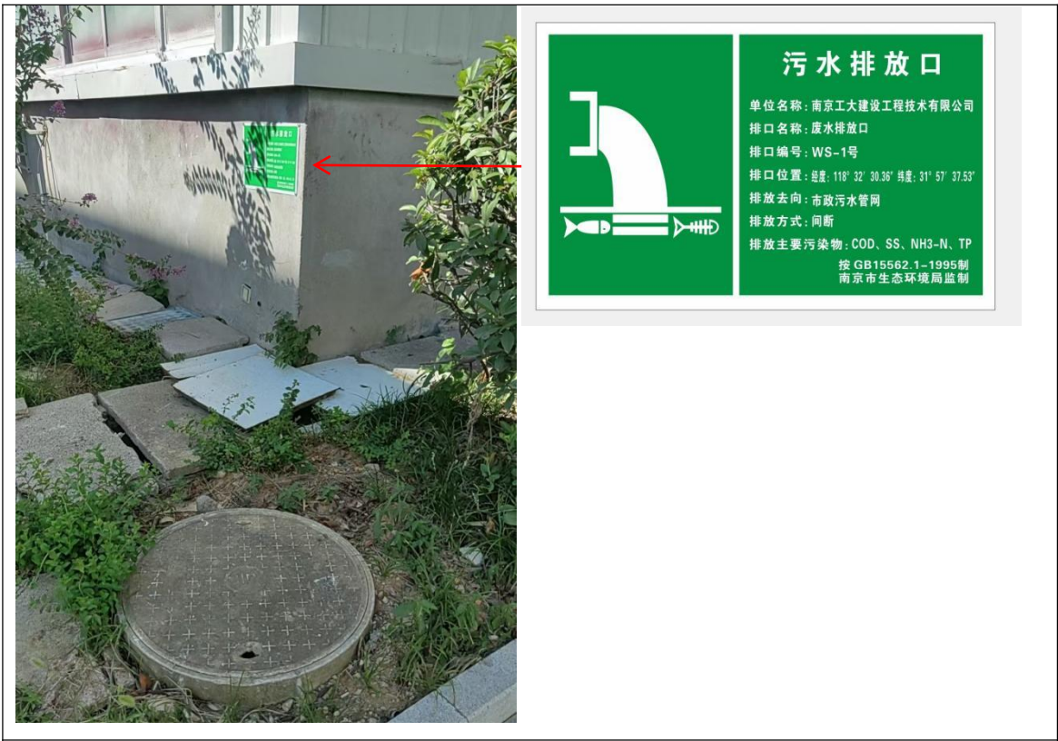
污水排口及标识牌
